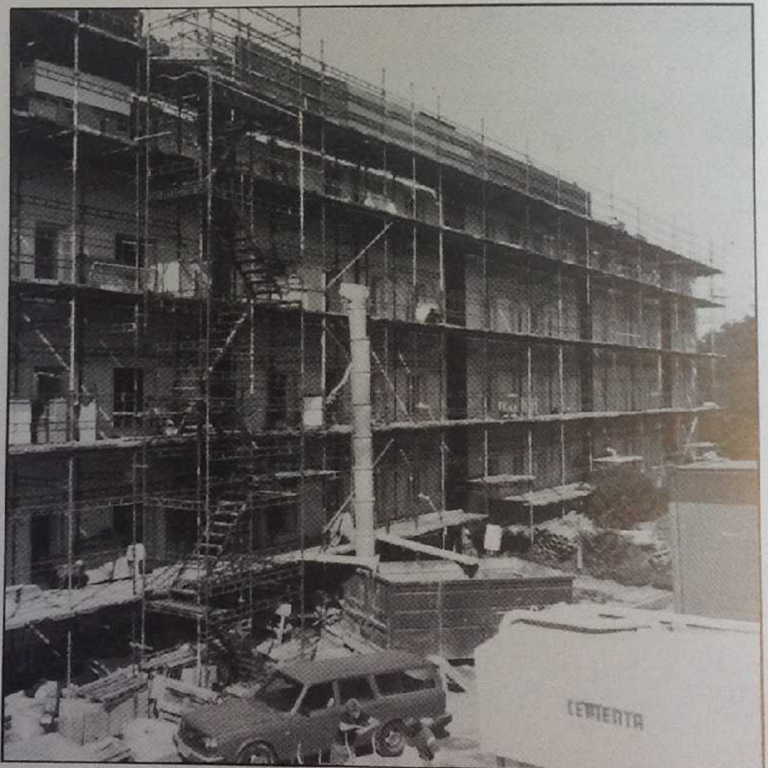
Renoveringen är här i full gång. Kanske lite svårt att känna igen sig för den som inte var med då.
