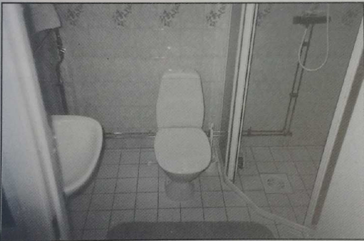
Borta är badkaret, som ersatts med duschkabin med glasväggar och skjutdörr.
